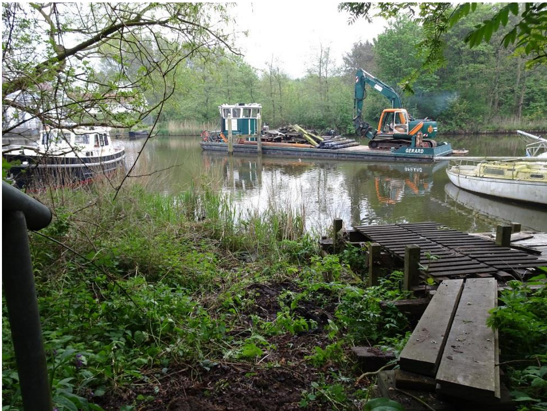
Vervanging steiger bij gemaal Leemans
